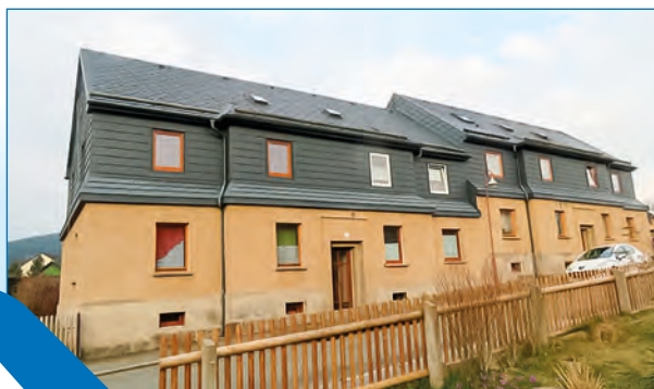
Baugenossenschaftsstraße 13/15, Lauter, Sanierung
